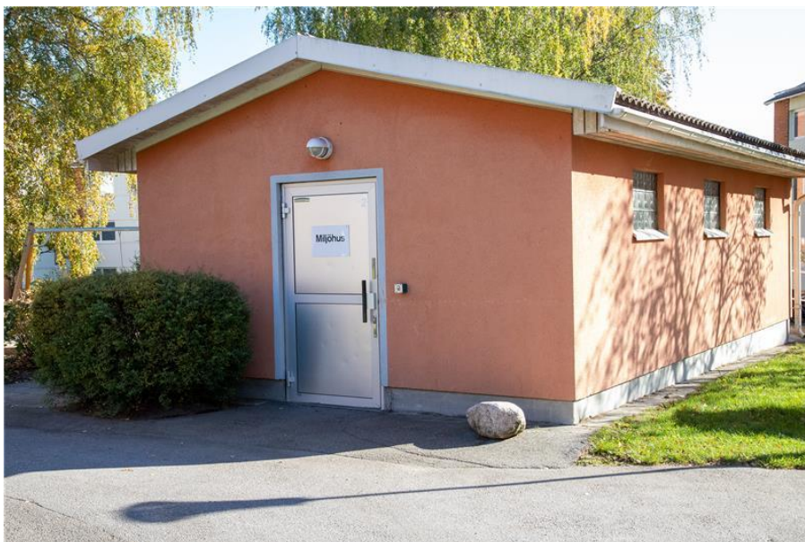
Figur 2 Avfallsrum med ljusinsläpp.
