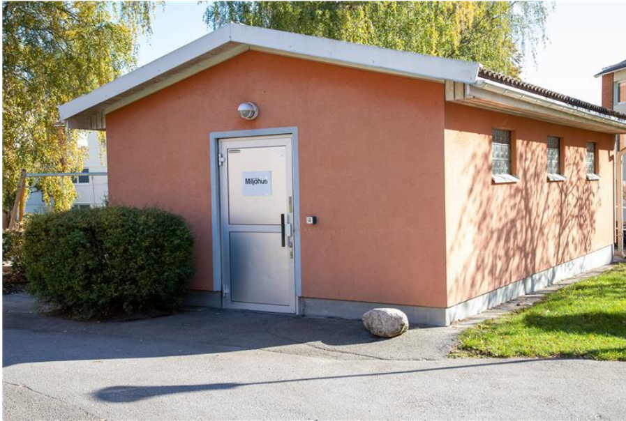
Figur 2 Avfallsrum med ljusinsläpp.
